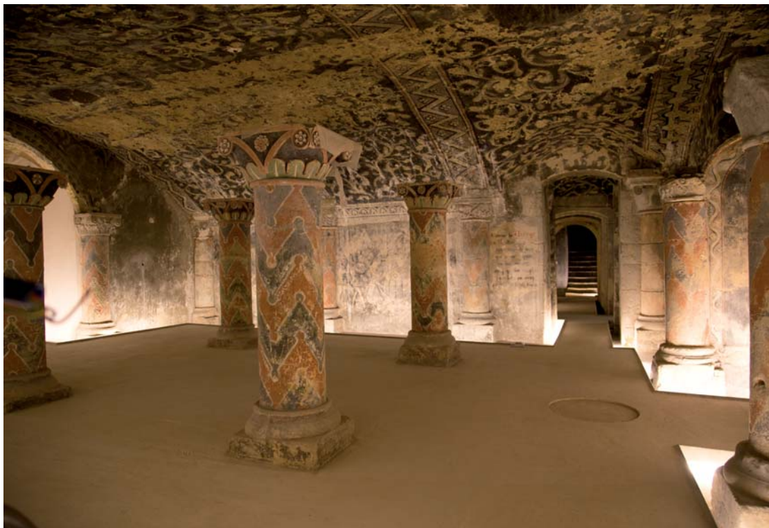
Vue de la crypte romane avec la restauration des nouveaux sols qui intègrent les sources d'éclairage.
