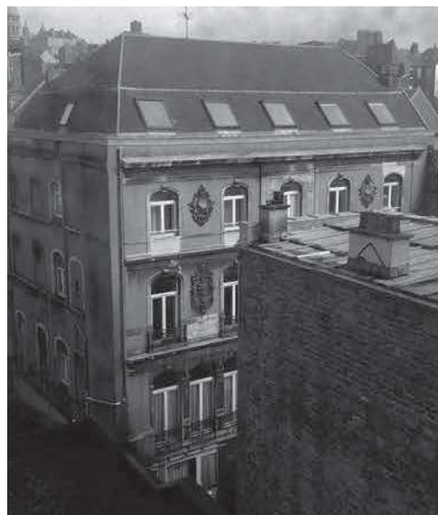
L'immeuble à l'arrière du 20 rue Neuve-Chaussée
