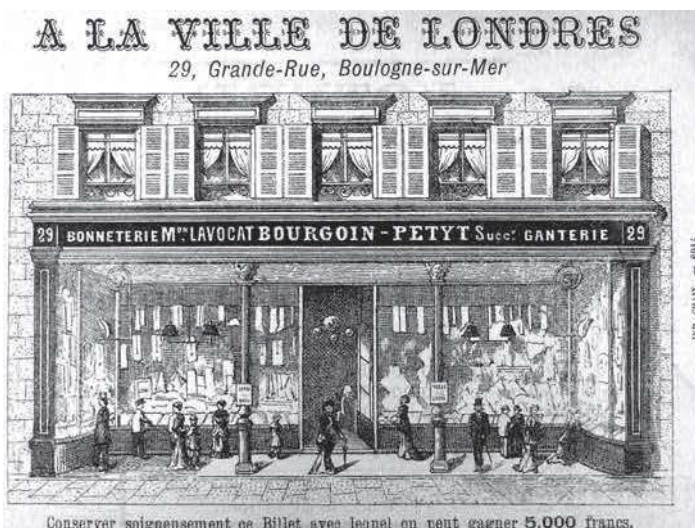
Billet de tombola daté de 1882 représentant le rez-de-chaussée de l'immeuble. Archives Municipales de Boulogne-sur-Mer.
