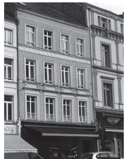
L'immeuble de nos jours. Photo A.M. Cojez
